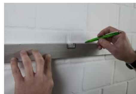
Um Vibrationen zu vermeiden muss der *RM Eco* mit allen vier Schrauben befestigt werden.
