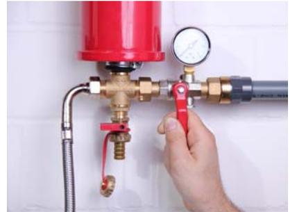
3.) Entlüftungshahn öffnen (Wassereimer unter Entlüftungshahn halten) und Pumpe durch Einstecken des Netzsteckers starten.
