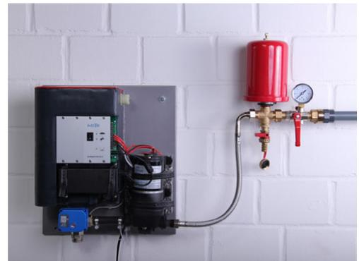
Der Vordruck des Ausdehnungsgefäßes muss überprüft werden (s. Kap. 5.5).
