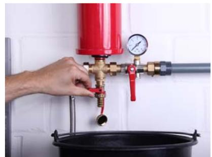
5.) Druckabsperrhahn öffnen und Leitung bis zu den Verbrauchern entlüften (z.B. mehrmals Toilettenspülung drücken).
