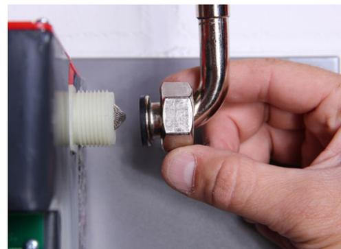
Die andere Seite des Flexschlauchs (Überwurfverschraubung) mit dem in dem in der Trinkwasserleitung montierten Absperrhahn verschrauben.
