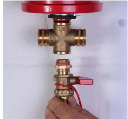
Danach wird der Druckabsperrhahn mit der flachdichtenden Überwurfverschraubung mit dem T-Stück verbunden. (Das Manometer wird bauseits am Manometer-Anschluss des Druckabsperrhahns eingedichtet.)
